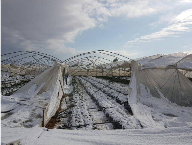
Ingenti i danni rilevati alle strutture delle colture protette
